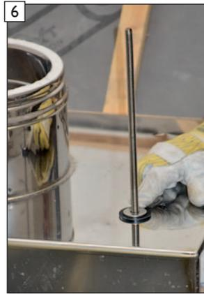
6 ... anschließend Unterlegscheibe aus Edelstahl (B) ...
