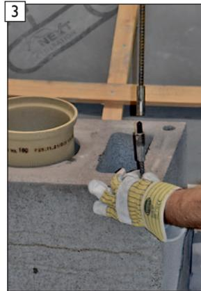
3 Zweiten Bewehrungsstab mit Doppelhülse kraftschlüssig verschrauben.
