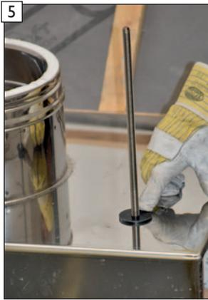
5 Zuerst die Dichtscheibe (Unterlegscheibe aus Kunststoff (A)) ...
